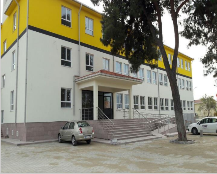
AYVACIK KÜÇÜKKUYU İLKÖĞRETİM OKULU YAPIM İŞİ
