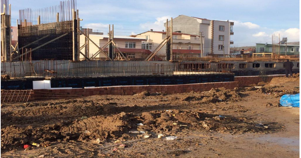
Ezine Yeni İlkokulu Yapım İşi
