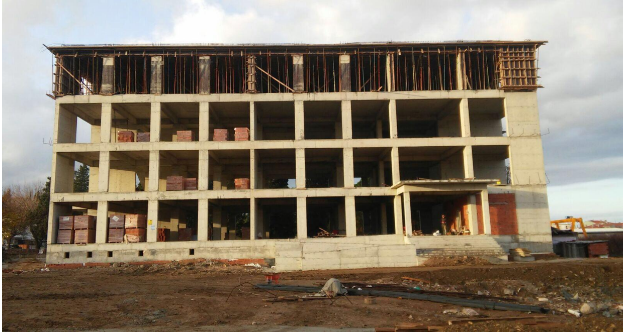
Bayramiç İmam Hatip Lisesi Okul Binası Ve 100 Kişilik Yurt Binası Yapım İşi
