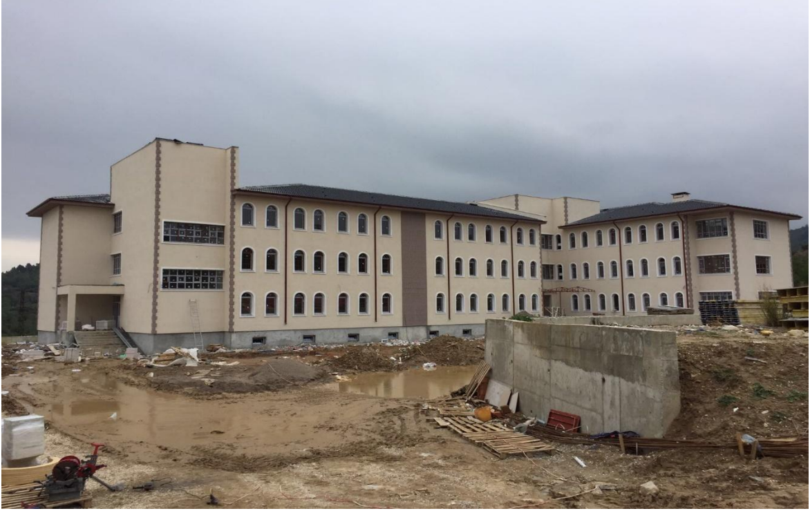
Kepez 24 Derslikli Anadolu Lisesi Yapım İşi
