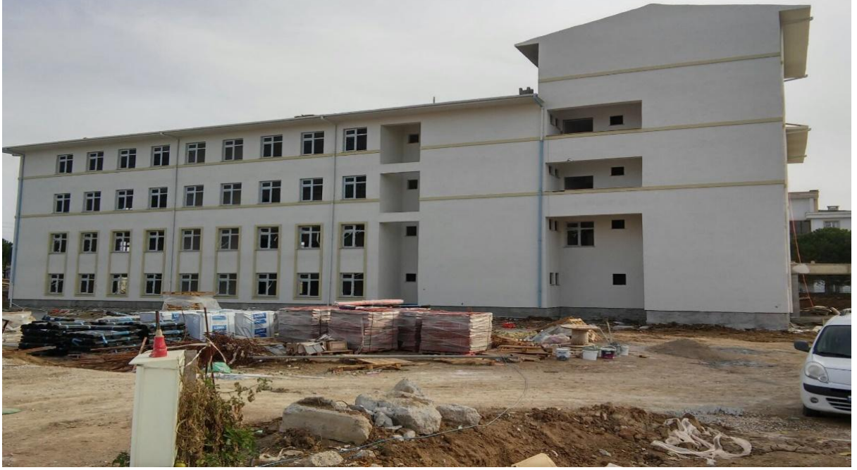
Merkez Mesleki Ve Teknik Anadolu Lisesi Yapım İşi
