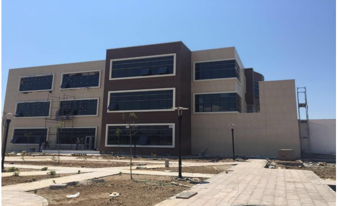
112 Acil Çağrı Merkezi İkmal Yapım İşi
