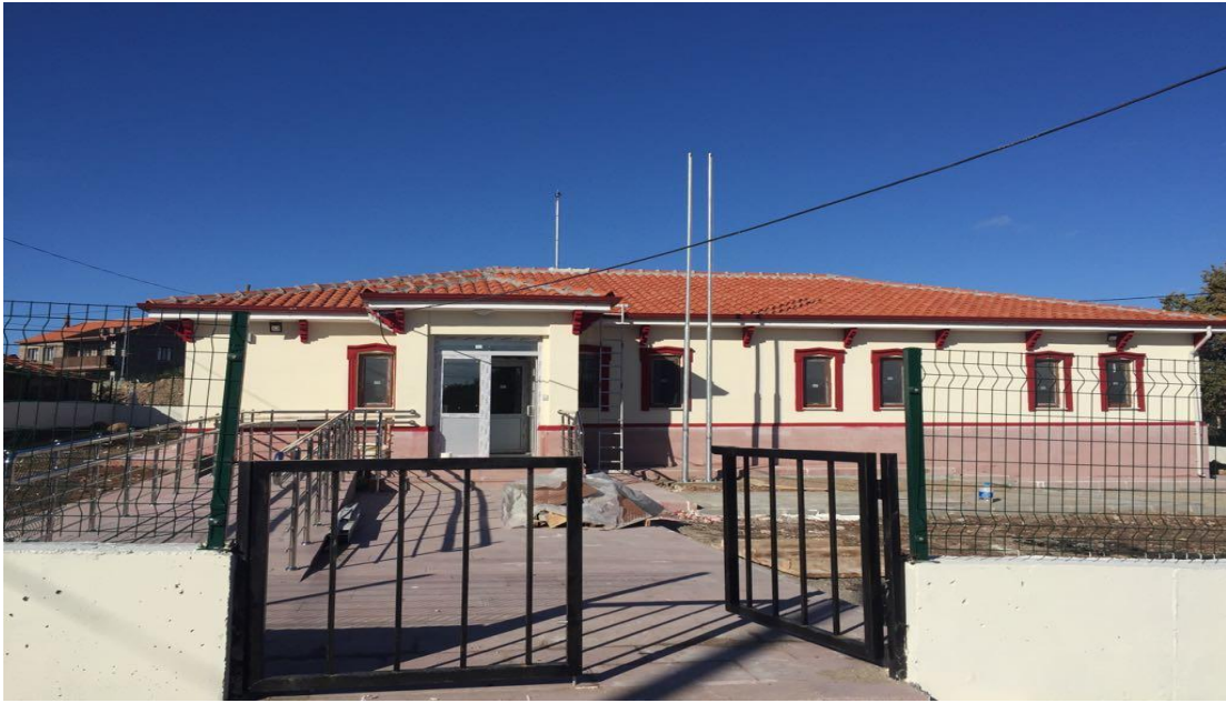
Ayvacık Korubaşı Sağlık Evi Yapımı
